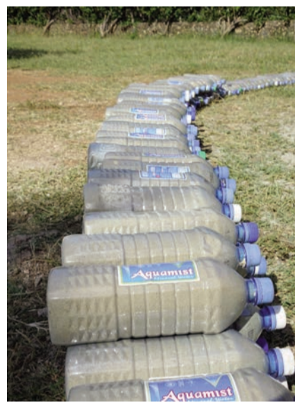
Lange Reihe mit PET-Flaschen, bevor sie vermauert werden.
