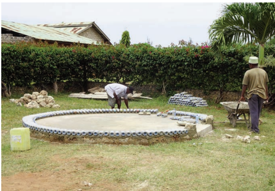
Die erste Reihe wird gemauert – ein wichtiges Moment.
